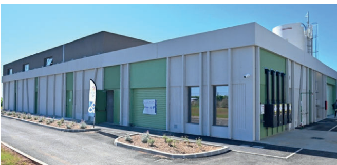
La nouvelle usine de traitement d'eau potable Valédeau qui approvisionne Jacou.
