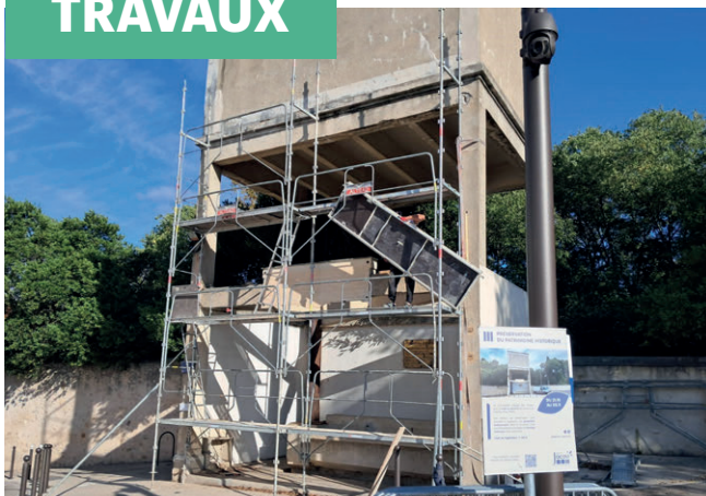
Le lavoir durant la phase de travaux
