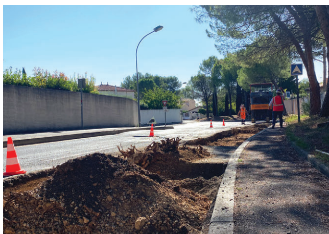
Une purge racinaire a été réalisée sur l'Avenue Pierre de Coubertin
